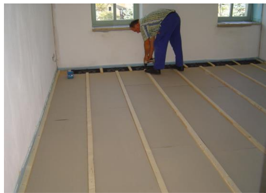
Bild 3. Auslegen der Umlenkbogenbleche
