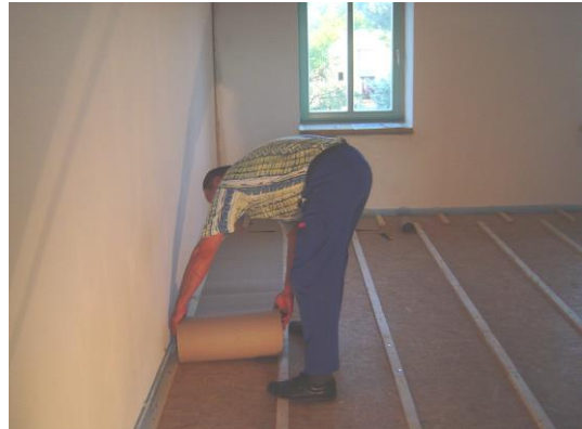
Bild 2. Auslegen des Wellkartons
