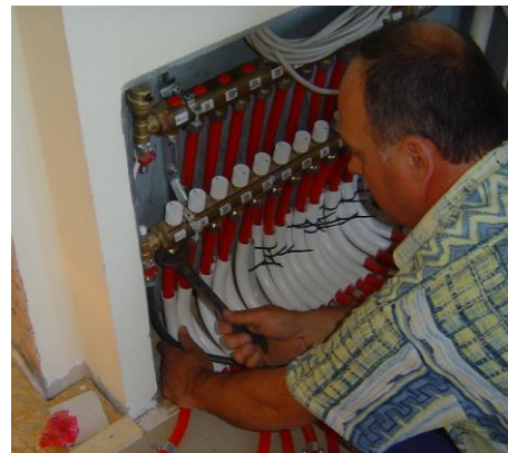
Bild 7. Anschluss an HKV
