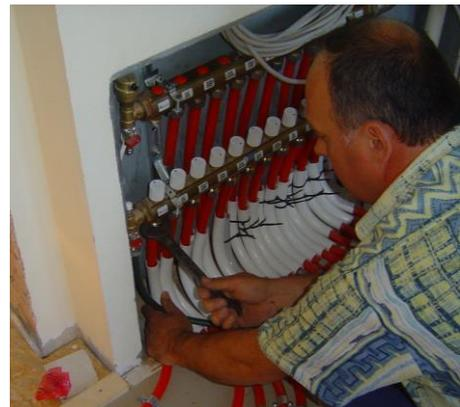
Bild 6. Anschluss an HKV
