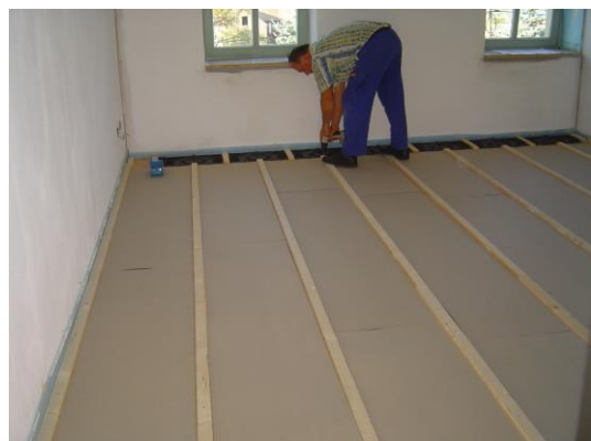
Bild 3. Auslegen der Umlenkbogenbleche
