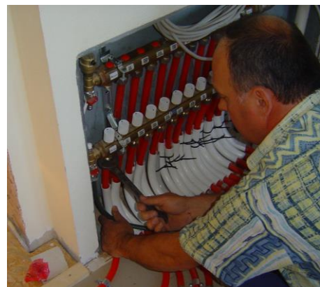
Bild 7. Anschluss an HKV
