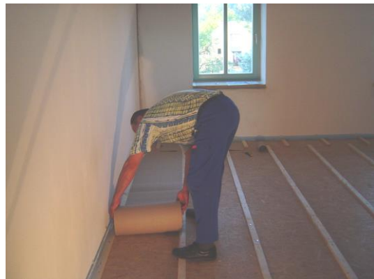
Bild 2. Auslegen des Wellkartons
