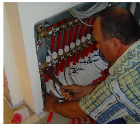
Werte (siehe Tabelle im Verlegeplan „UM“) einzustellen. Dazu ist als erstes der Sicherungsring zu lösen (gegen Uhrzeigersinn), das Ventil zu schließen (in Uhrzeigersinn) und dann die entsprechende Anzahl an Umdrehungen wieder zu öffnen (gegen Uhrzeigersinn). Als letztes wird die Position mit dem Sicherungsring fixiert (in Uhrzeigersinn);
